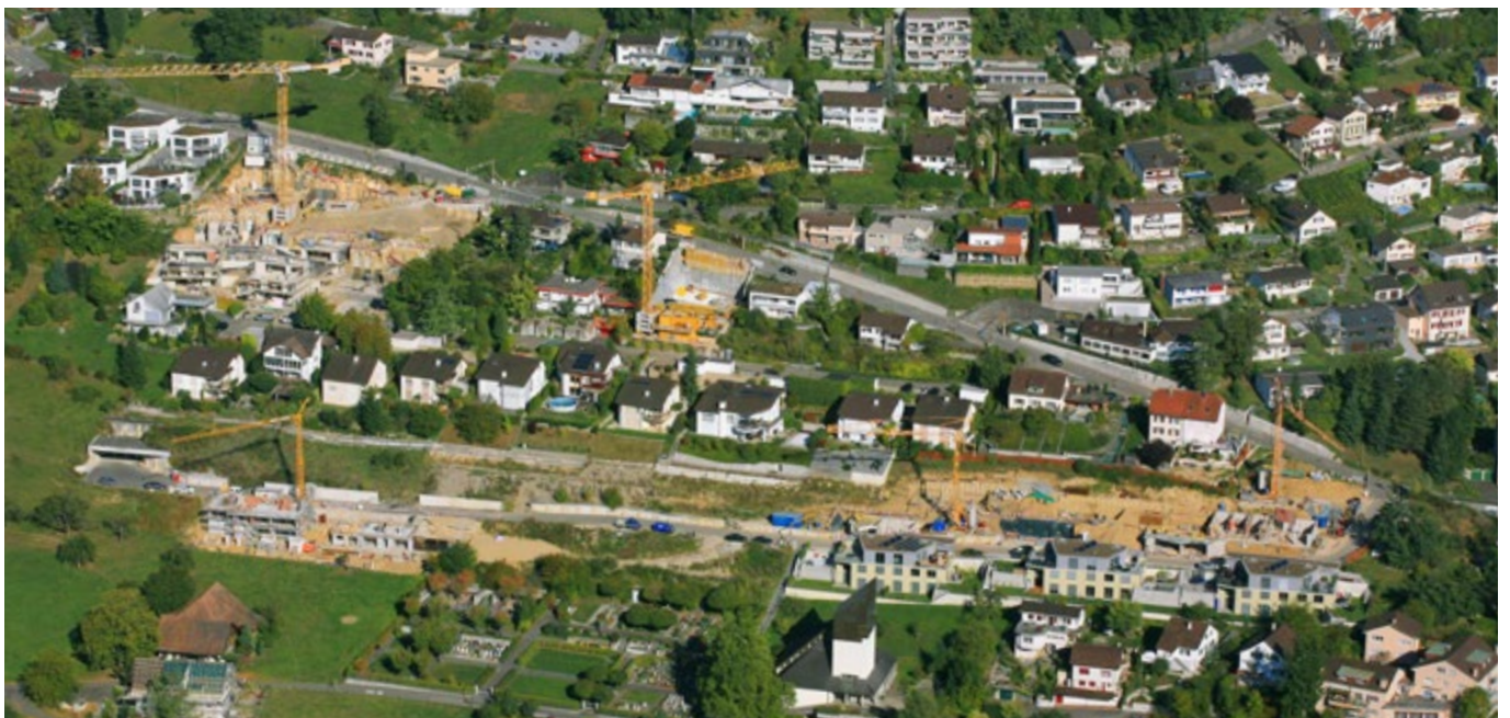
Bei Baubeginn ist vieles schon entschieden: Den grössten Einfluss auf die CO 2 -Emissionen in der Nutzungsphase hat der Bauherr bei der Planung.
